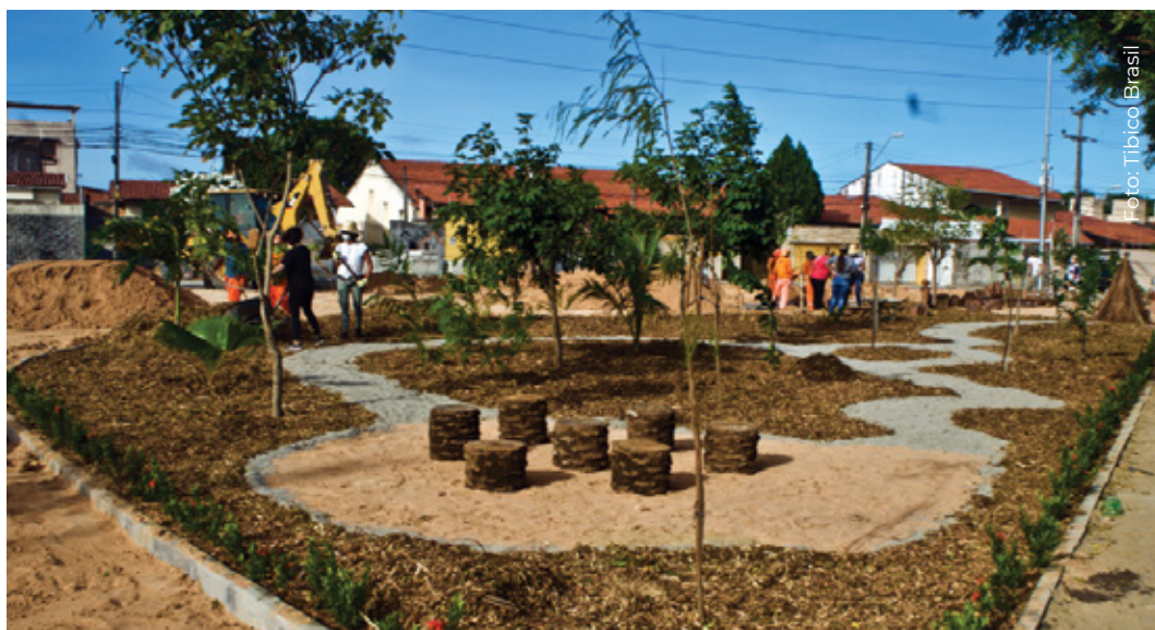
Construção de parquinho naturalizado em Fortaleza, CE
